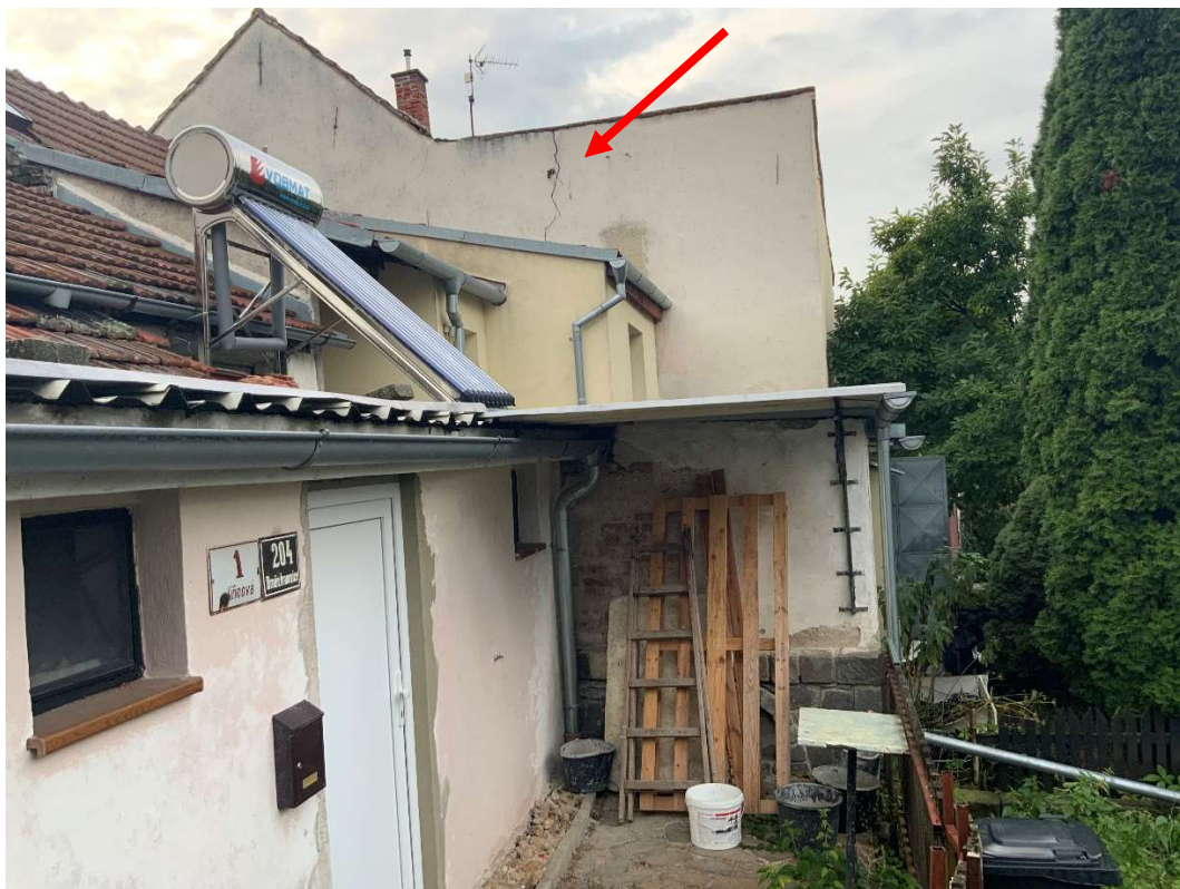
Trhlina ve zdivu v 1.NP mezi podélnou a příčnou nosnou stěnou přístavby
