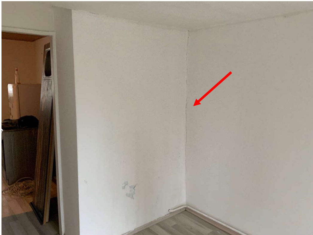
Trhlina ve zdivu v 1.NP mezi podélnou a příčnou nosnou stěnou přístavby
