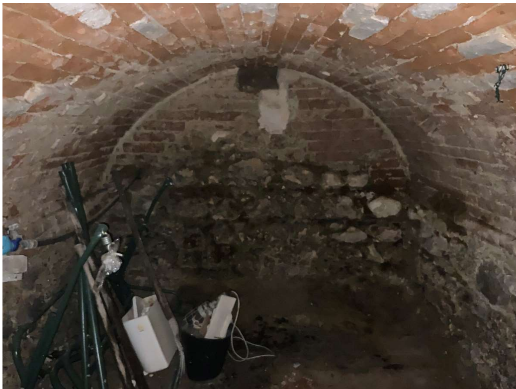
Sklepení s valenou klenbou z plných cihel
