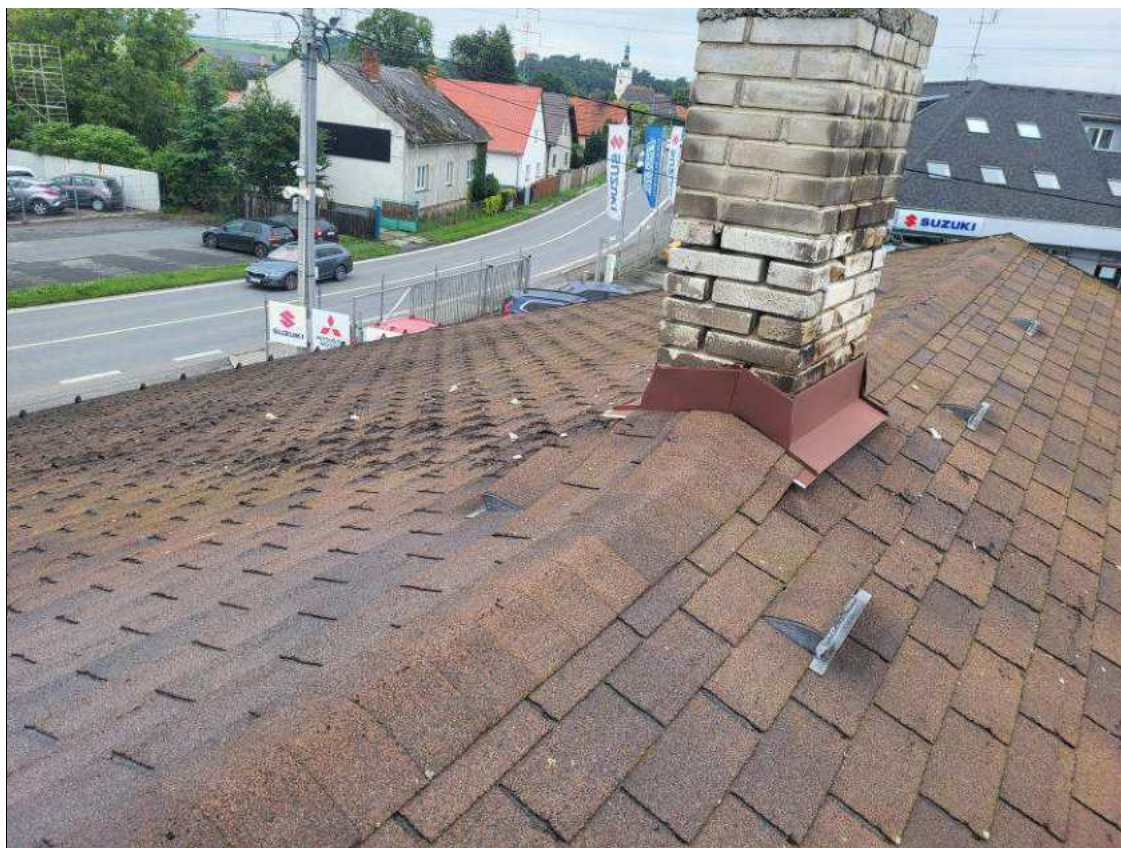
Obr. rozklad zdiva komínu
