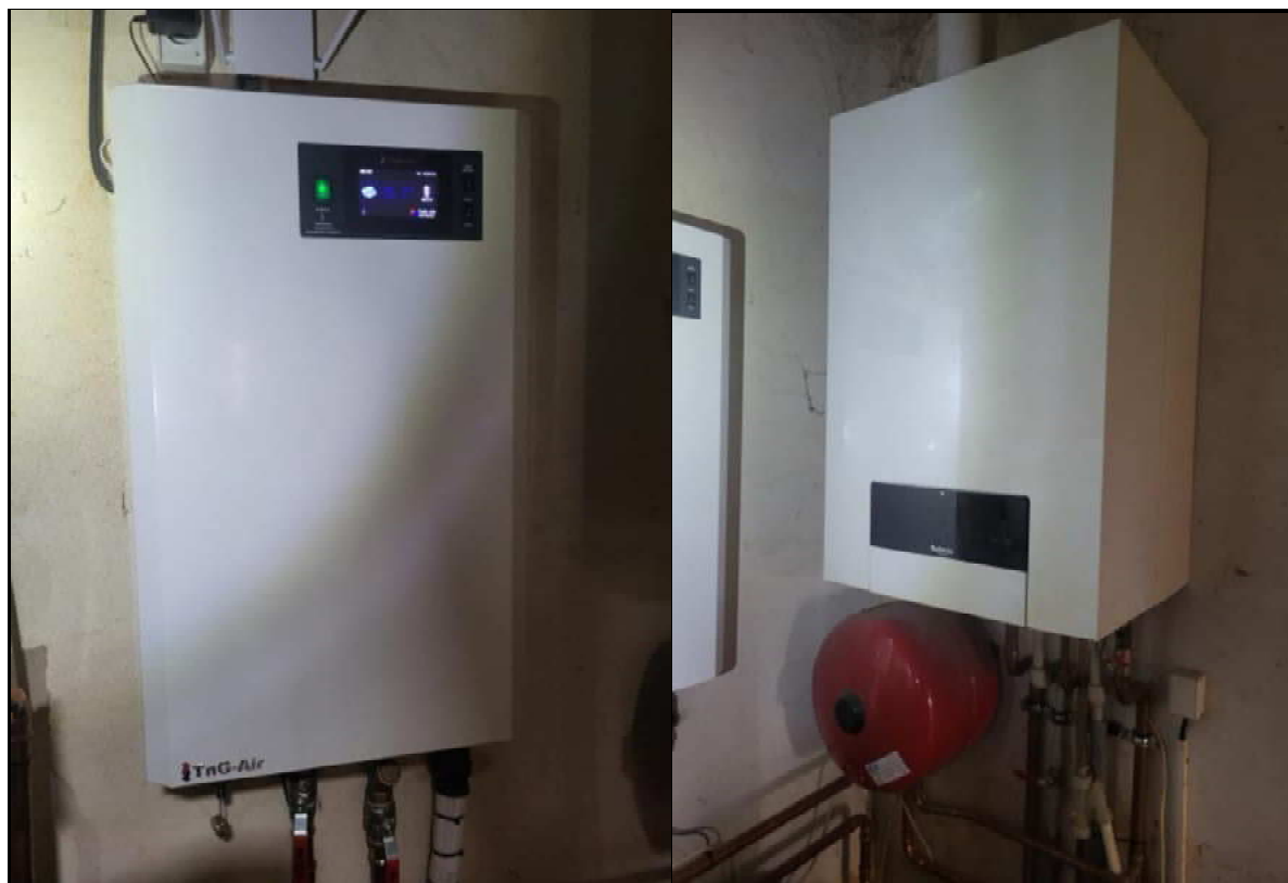
Obr. vnitřní jednotka TČ a kondenzační kotel s expanzomatem na rozvodech
