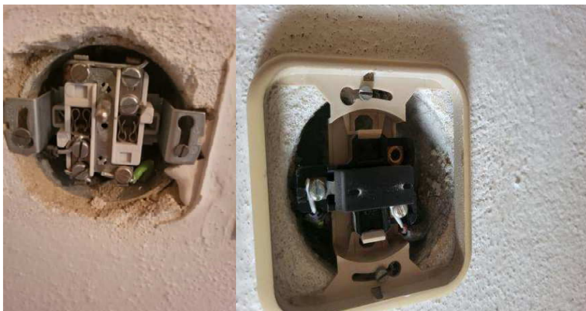
Obr. původní hliníková elektroinstalace
