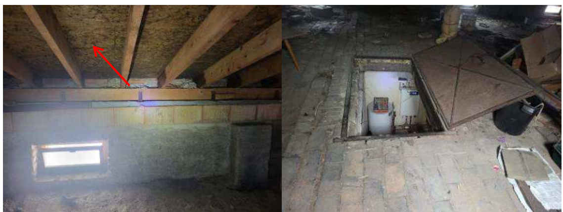
Obr. OSB napadené plísní, zvýšení vzdušné vlhkosti přispívá nedostatečný tepelně izolační vstup
