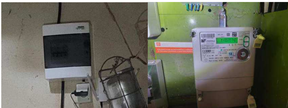
Obr. rozvaděč TČ, dvou tarifní elektroměr
