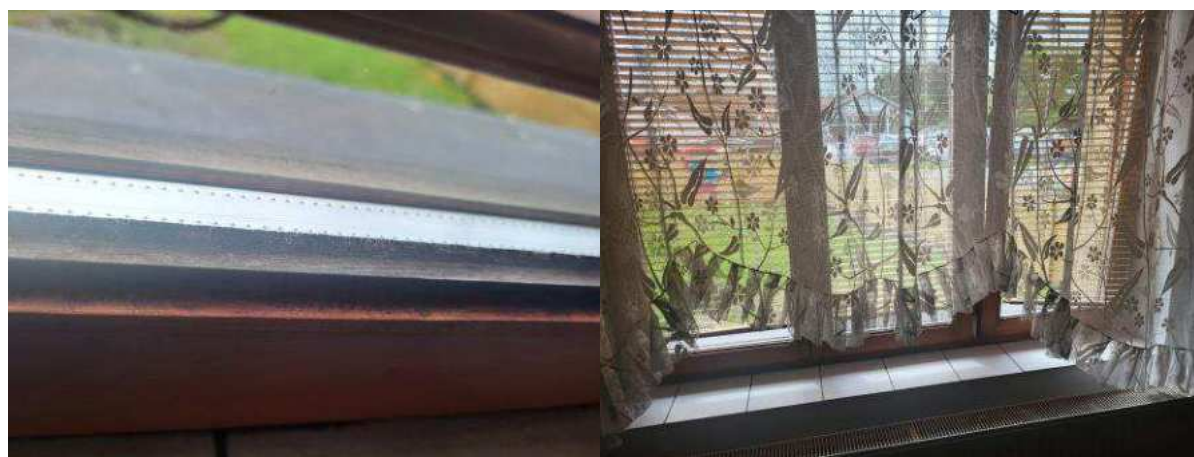
Obr. okna původní dřevěná zdvojená
