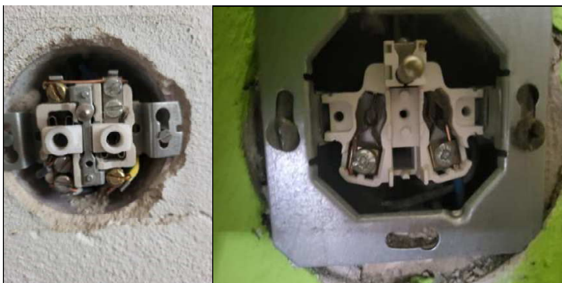
Obr. původní hliníková elektroinstalace
