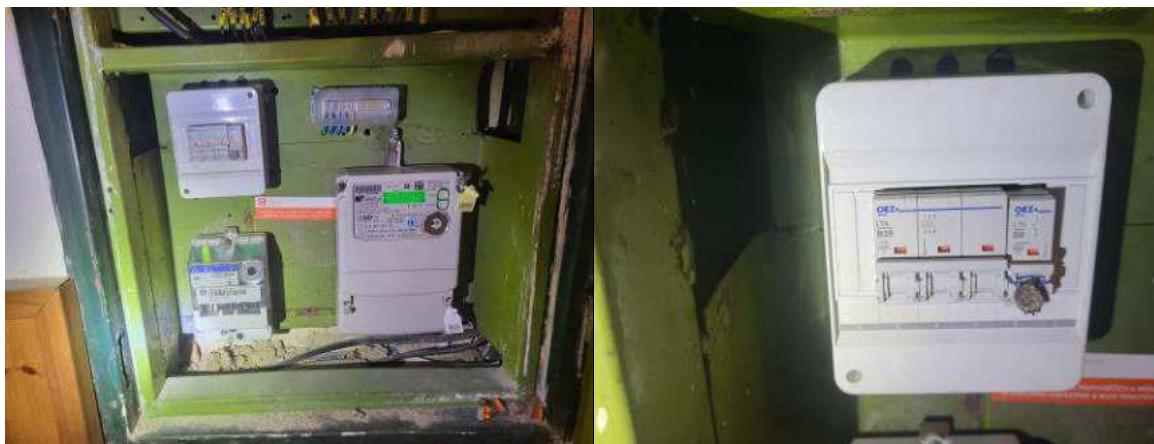
Obr. rozvaděč TČ, dvou tarifní elektroměr
